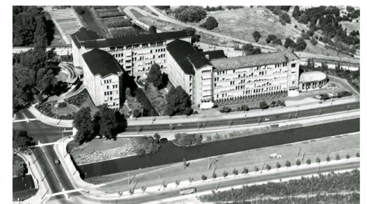
Rond 1982 wordt het gebouw, dan al niet meer in gebruik bij de KLM, opnieuw uitgebreid met een nieuw bouwdeel, dat bekend staat als de Saxofoon. De bouw van de Saxofoon grijpt vooral in op de inrichting aan de noordzijde van het historische kantoorgebouw. Het gebied wordt op een relatief sobere wijze ingericht. Er is sprake van relatief veel verharding in de vorm van parkeerplaatsen en brede voetgangersgebieden. De 'groene' inrichting beperkt zich tot een aantal zones met gras waarin een boombeplanting van verschillende Prunussen wordt aangeplant.
